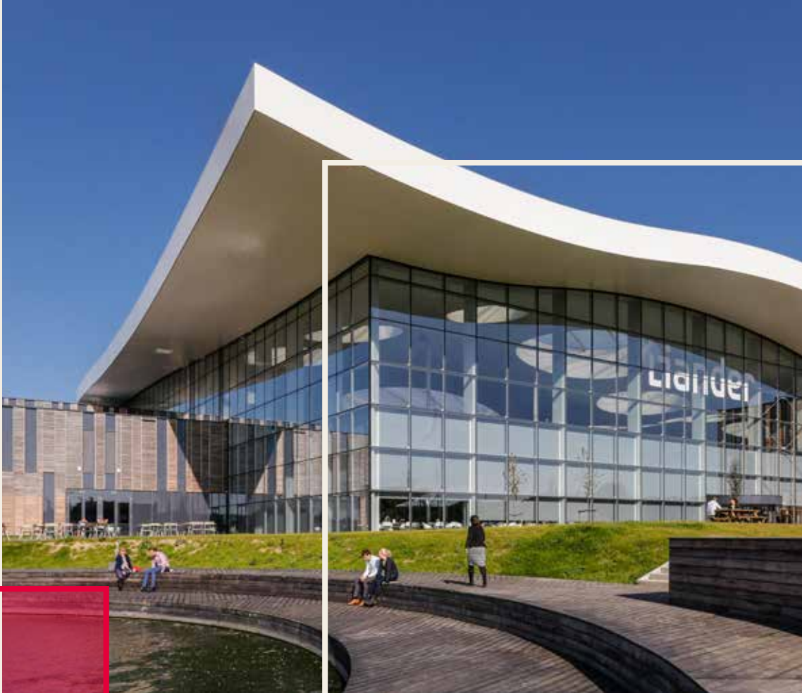
Gebouw van Liander in Duiven. Foto met dank aan Alliander. ©
