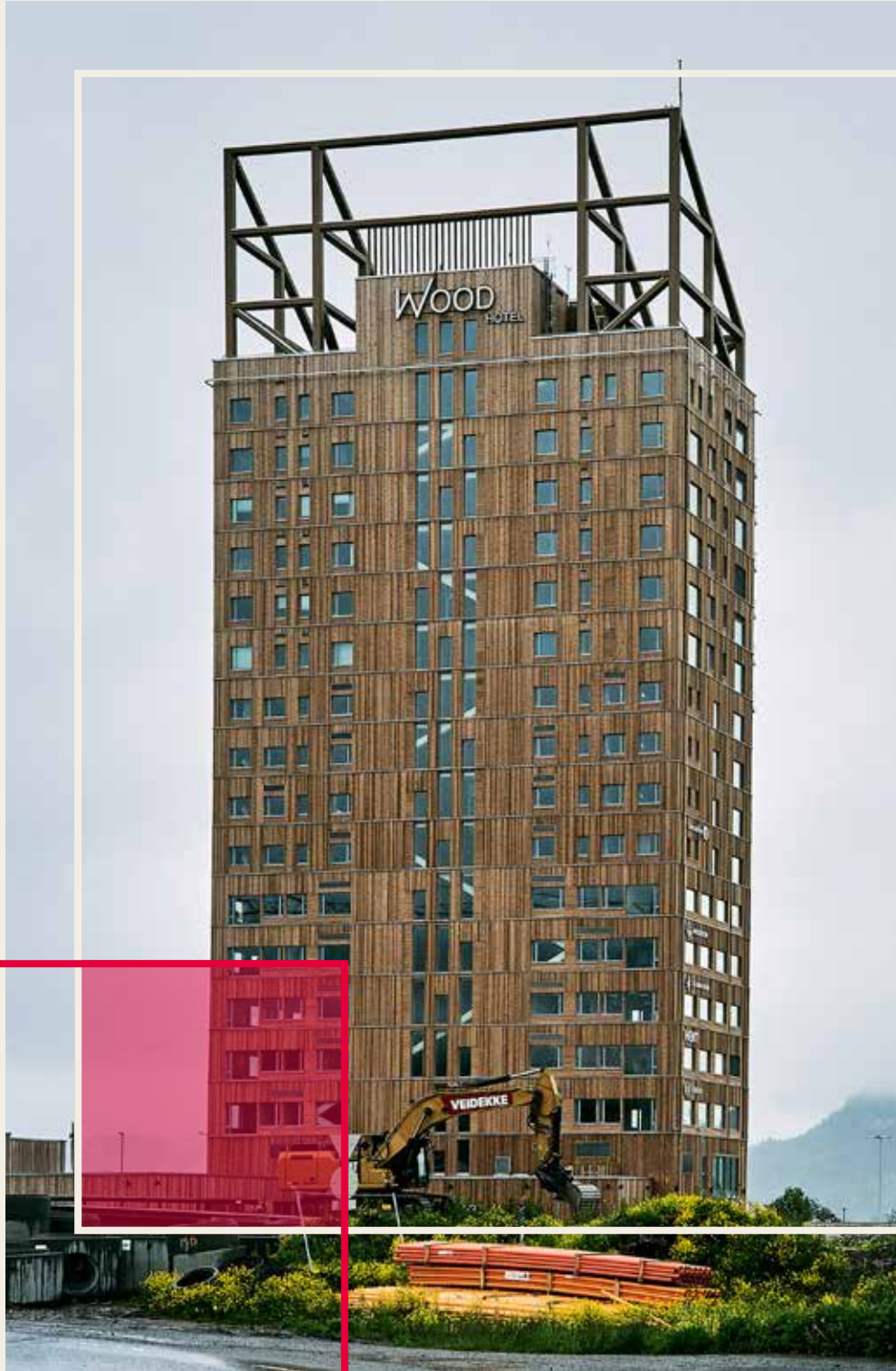
Mjøstårnet, wolkenkrabber van hout in Noorwegen. Foto door Øyvind Holmstad, 2019. CC BY-SA 4.0
